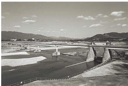
豊川用水事業により松原用水と牟呂用水の取水口を統合した牟呂松原頭首工が完成(昭和43年)
