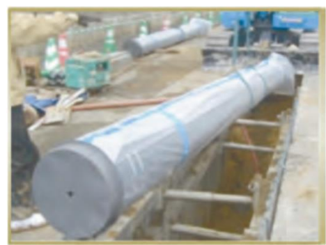
ポリエチレンスリーブ装着状況
