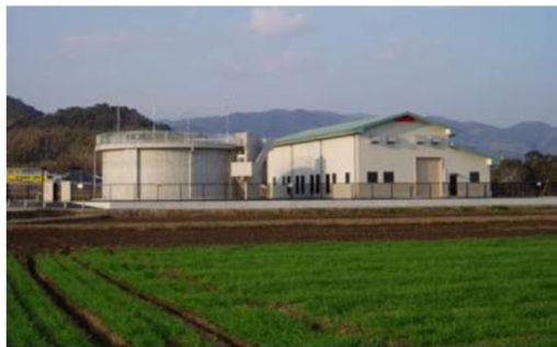
城原金立揚水機場
