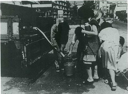
給水車が出動 (S53年渇水)
