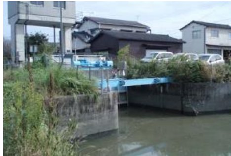
田川城島2号排水樋門
