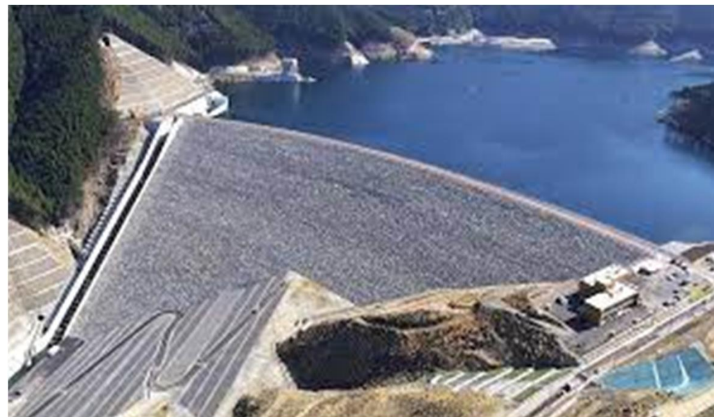
小石原川ダム
