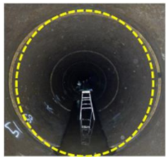
管内面のひび割れ 管路のたわみ (黄線が真円)
