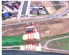
【耐震性能の不足】
