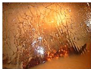
管内面のひび割れ 管路のたわみ (黄線が真円)
