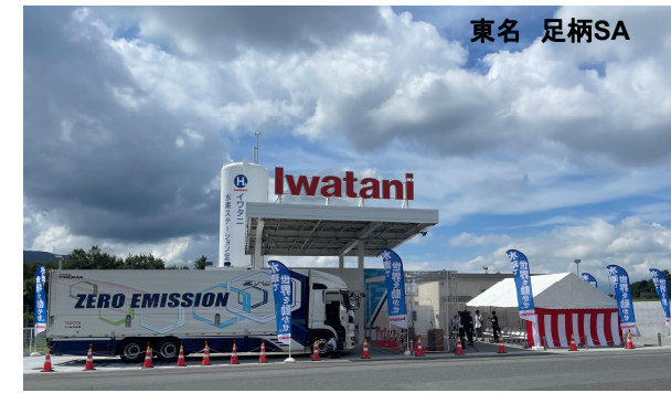
水素ステーションの設置
