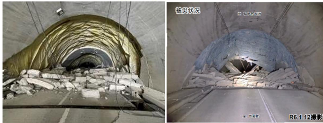
大谷トンネル(国道249号)
