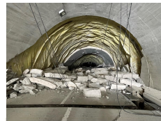
写真① 国道249号大谷トンネルの崩落 (R6.1.6撮影)
