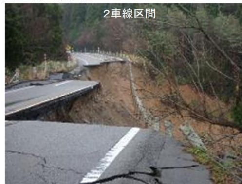
4車線／2車線区間の崩壊事例
