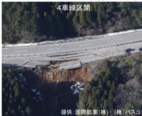
4車線／2車線区間の崩壊事例
