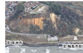
写真③ 国道249号法面崩落 (R6.1.2撮影)
