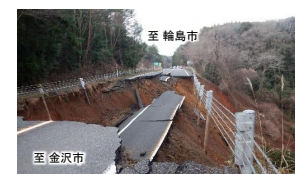
写真⑤ のと里山海道(徳田大津IC付近)道路崩壊 (R6.1.2撮影)
