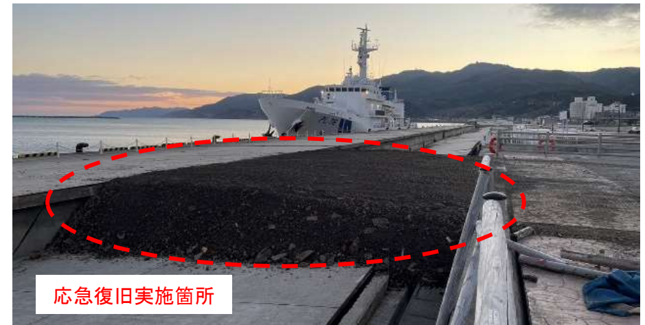
岸壁への車両のアクセスを確保するための応急復旧の実施（輪島港、1/5）
