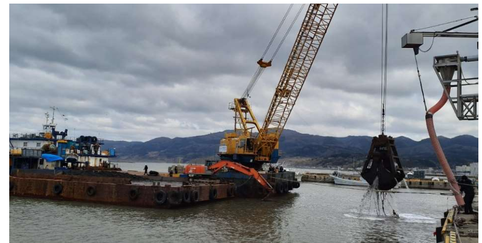
地盤の隆起等により水深が浅くなった港内の啓開作業の実施（輪島港、2/16）
