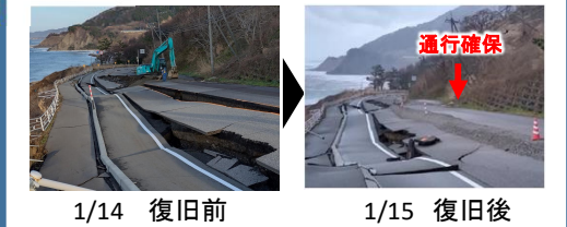
写真② 国道249号緊急復旧完了
