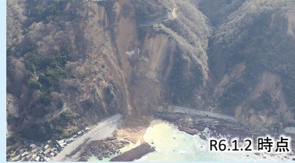
写真③ 国道249号法面崩落
