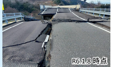
写真④ 国道249号鳥川橋
