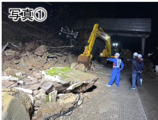
写真① 県道1号 輪島市三井町での啓開作業(1月3日撮影)
