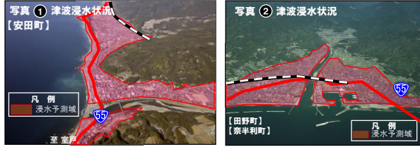
図1 津波浸水状況(安田町、田野町) 【写真②：高知県提供】
