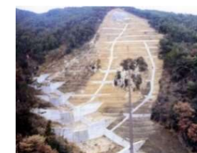
施工中 (昭和55(1980)年)
