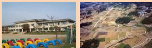
小学校校舎の整備
