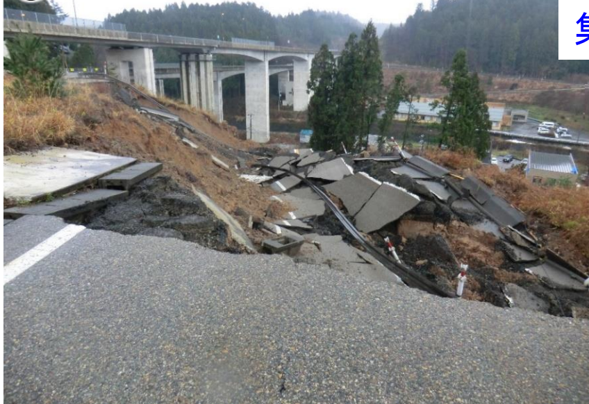
②嵩上げ盛土の大規模崩壊
