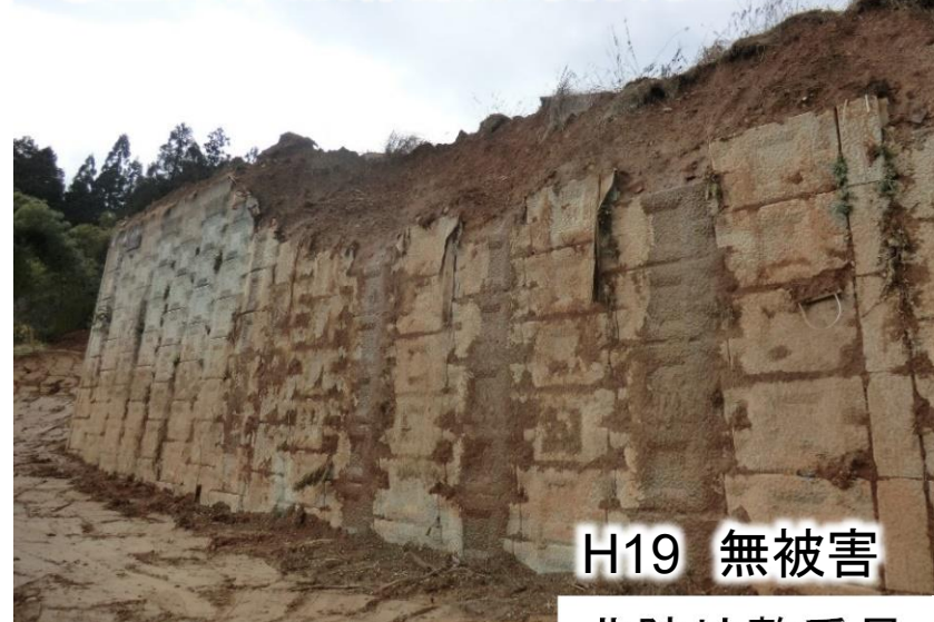
③壁面材(残存部)に変状なし
