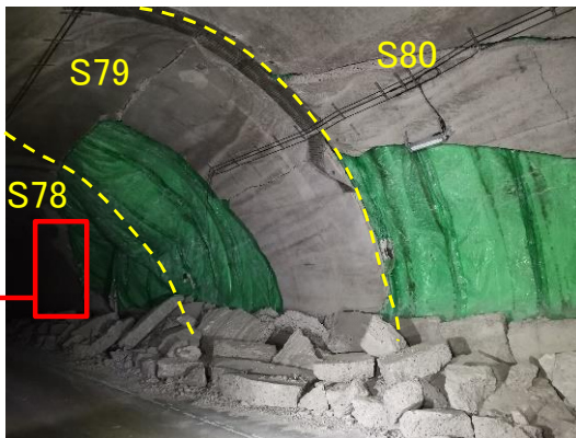
S78～80 南から北向きに撮影 (膨張性地山により施工に難渋した区間付近)
