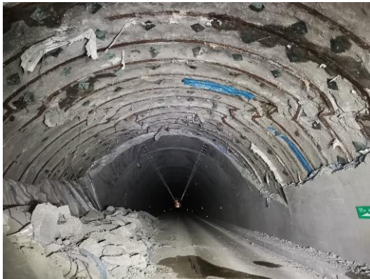
S103～105 南から北向きに撮影
