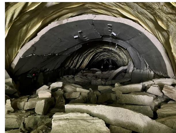
S7付近(南から北向き)
