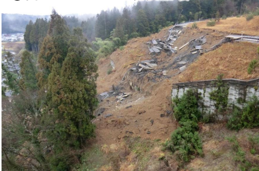
②嵩上げ盛土の大規模崩壊
