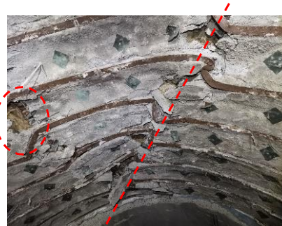
一部地山を視認
