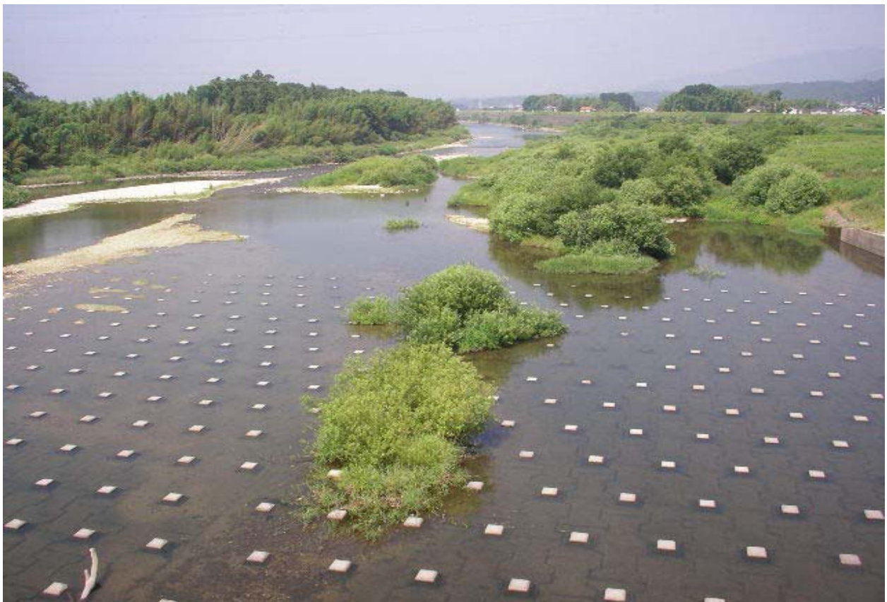
豊川 牟呂松原頭首工直下流 平成17年6月27日（月）10:00
