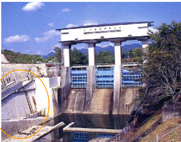
大野頭首工の全景 (写真の左側に魚道が設置)
