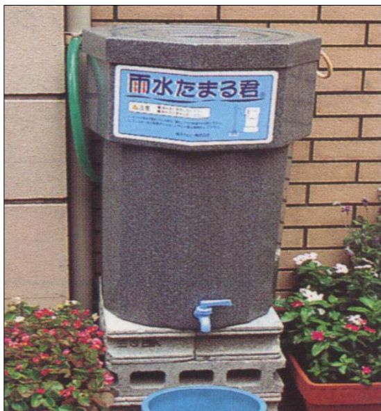
雨水貯水槽の例
