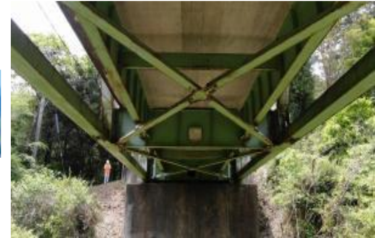
テスト飛行で撮影した橋梁の下面
