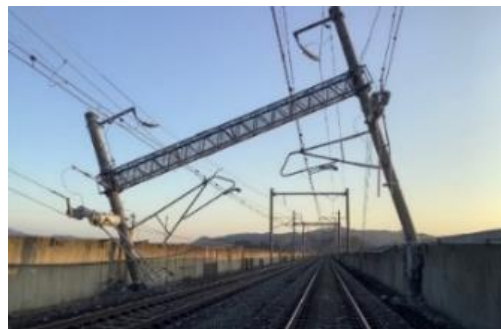
東北新幹線の電柱傾斜
