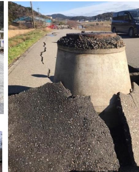
下水道マンホールの浮き上がり（輪島市）
