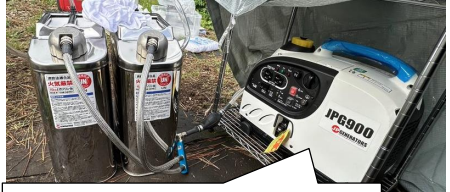
長時間無給油運転可能な発電機 の設置作業
