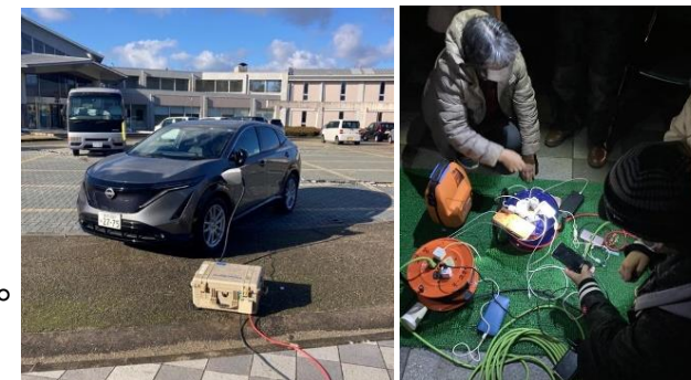
避難所でスマートフォンの充電等に活用 (令和6年能登半島地震時)
