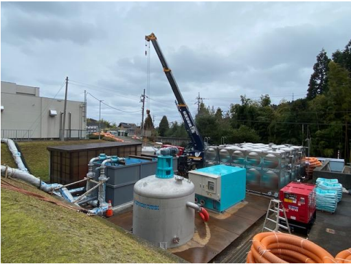
浄水場での活用（珠洲市宝立浄水場）
