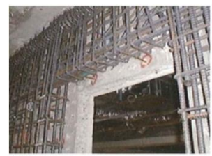
処理場の耐震化(躯体補強)
