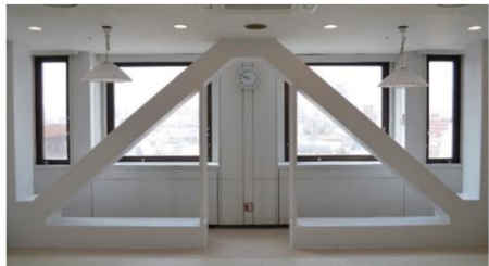
ブレース補強工法
