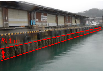
地盤の隆起(輪島港)
