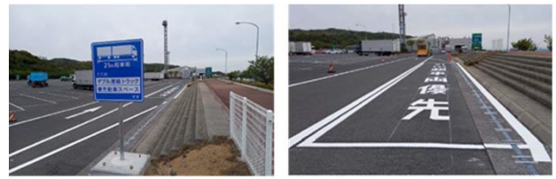
整備事例: 淡路SA(上り)
