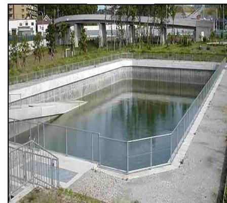
河川協議の結果、道路排水を一時的に貯留し、流量を調整しながら処理するための調整池を追加。
