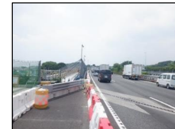
大和TN付近渋滞対策工事状況(下り線) 4 (R6.7時点)
