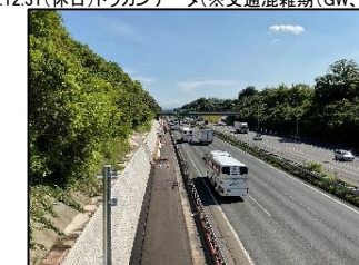
高坂SAランプ付近 舗装工事状況(R6.7時点)
