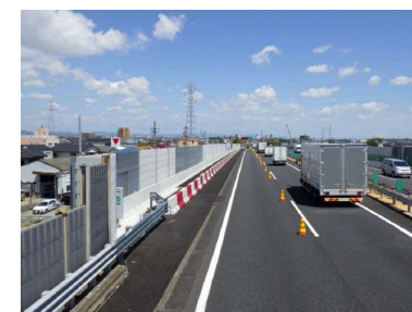
渋滞対策工事状況(上り線) (R6.6時点)
