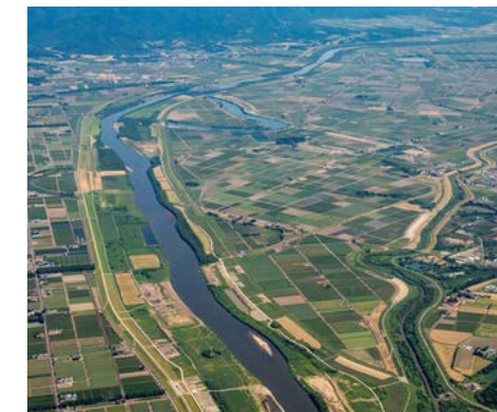
▼ 流域治水の推進 (石狩川と施工中の北村遊水地)
