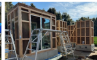
建具試験体と基礎貫通配管試験体
