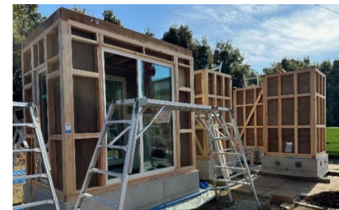
建具試験体と基礎貫通配管試験体
