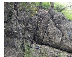
落石防護網の設置や落石の除去
