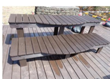
展望デッキの設置
