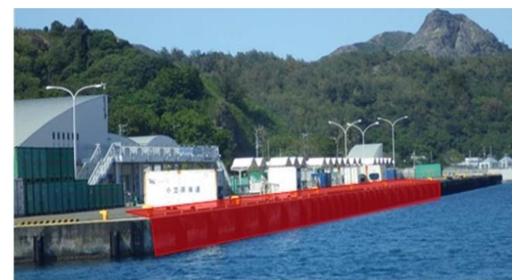
父島二見港 岸壁改良
