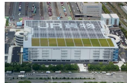
【JR貨】東京レールゲートEAST (1.8MW)
