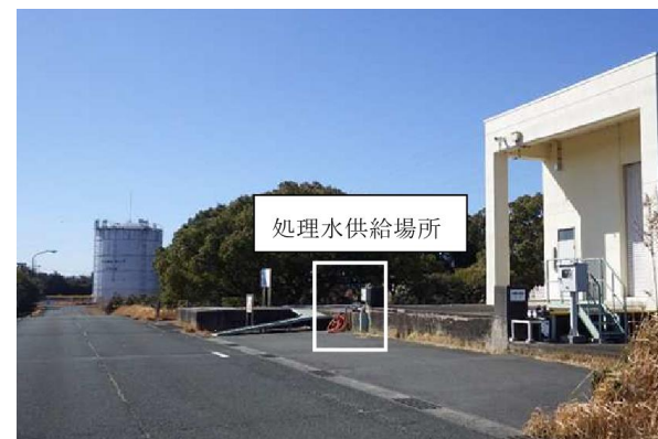
豊川浄化センター
