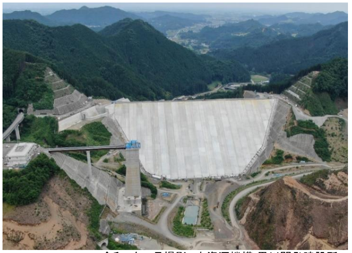
南摩ダム 全景
