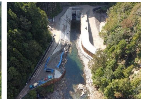
堤外仮排水路(呑口部)
