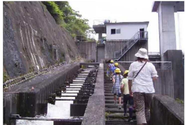
魚道の見学(大野頭首工)
