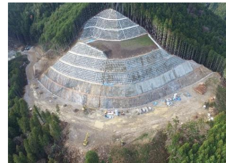
左岸頂部掘削
