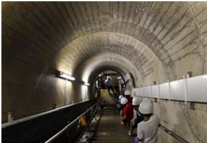
大島ダム(監査廊内)見学
