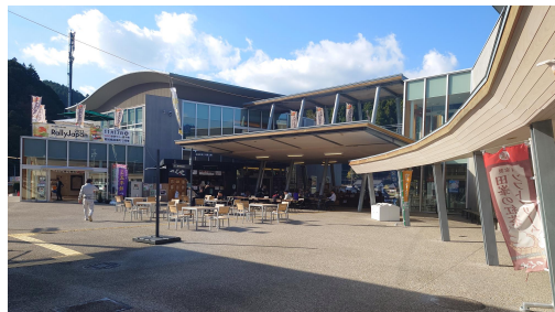
水源地域対策事業（道の駅したら）
