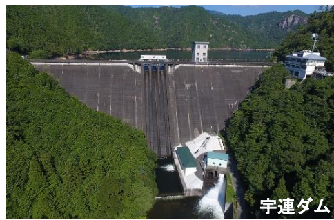
豊川用水施設 (水資源機構) S42完成
