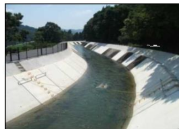
コンクリートライニング打換
