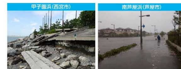
台風21号による被災状況
