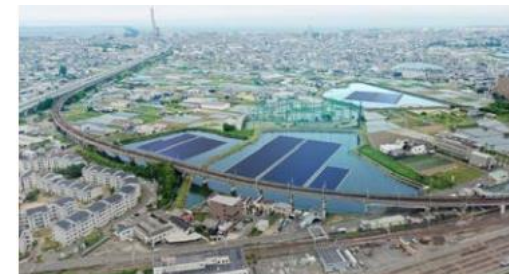
三井住友建設の水上太陽光発電 より
