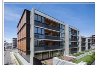
アネシス茶屋ヶ坂 設計施工：清水建設 竣 工：2020年7月
