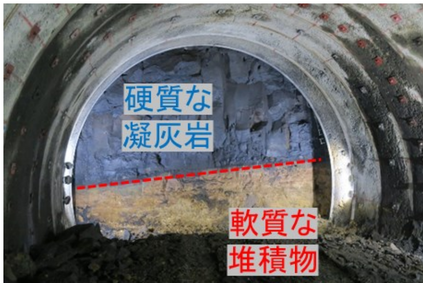
硬軟が混在した地山の施工例
