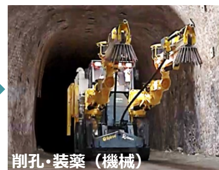
自動化・遠隔化施工の例 (削孔・装薬作業の自動化)
