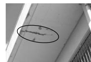
校舎等の天井・壁面 ひび割れや剥離
