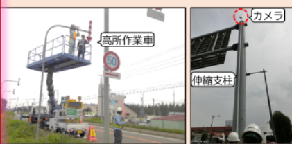
高所作業車や伸縮カメラによる点検 → 人力による診断
