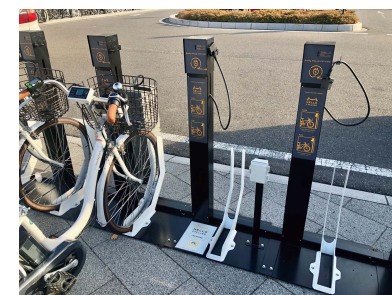
シェアサイクルの 充電サイクルポートの設置
