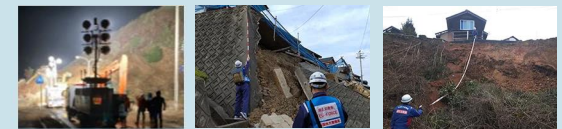
照明車を活用した昼夜を徹した道路の緊急復旧
