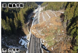
令和6年能登半島地震における切土崩壊（能越道（のと三井IC～穴水IC））
