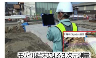
モバイル端末による3次元測量
