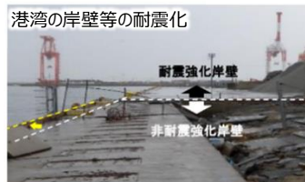
港湾の岸壁等の耐震化
