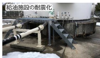
給油施設の耐震化
