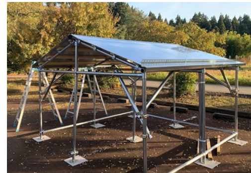
屋根除雪機械の実験用屋根の 設置（R5長岡市）
