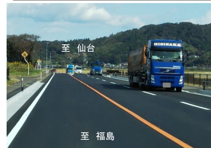
<開通後の状況>
