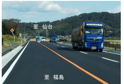
<開通後の状況>
