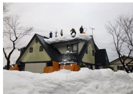
屋根雪下ろし作業の実施
