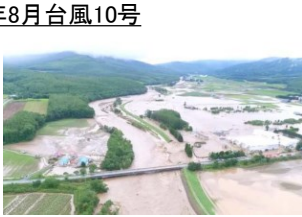
空知川の堤防決壊による浸水被害 (北海道南富良野町)
