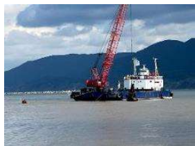
浚渫作業の状況 (R6.10)
