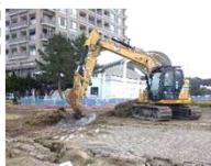
現地着工の状況 (R6.12)
