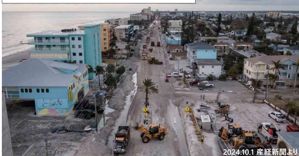
高潮による流入土砂の撤去状況 (9月28日)
