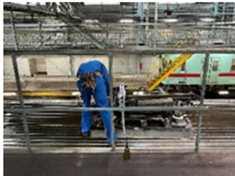
危険を伴う屋根上点検作業
