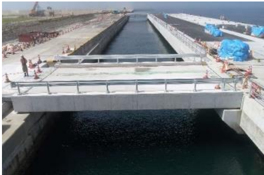
渡橋の架設状況
