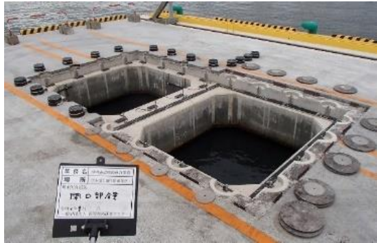
施工性確認試験実施状況(床版撤去)
