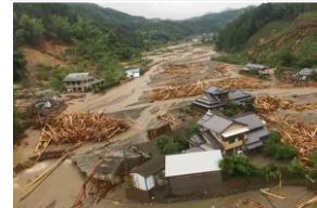
赤谷川における浸水被害 (福岡県朝倉市)
