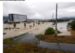
肱川における浸水被害 (愛媛県大洲市)
