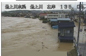
最上川における浸水被害 (山形県大江町)
