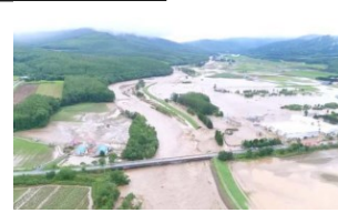
空知川の堤防決壊による浸水被害 (北海道南富良野町)
