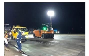
災害復旧工事の例
