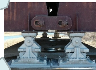
元の支承と同じ 形式で復旧
