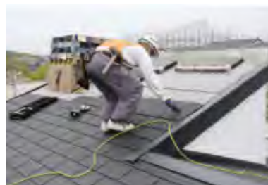
屋根の断熱化工事
