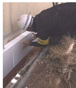
外壁の断熱化工事
