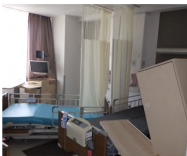
耐震構造の病棟の地震後の状況
