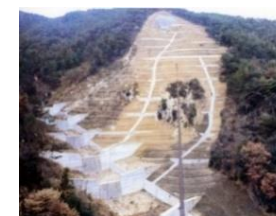
施工中 (昭和55(1980)年)
