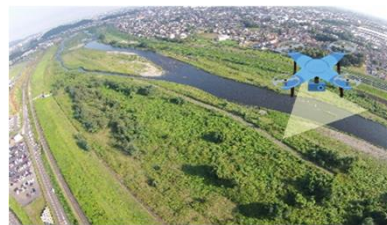
ドローンによる河川巡視
