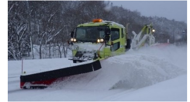
建設業（除雪オペレーター等）
