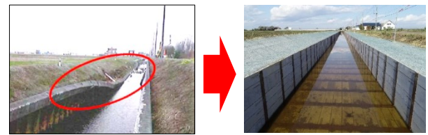
老朽化による排水路の倒壊 整備後の排水路
