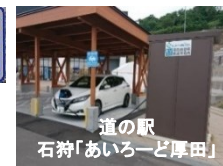
道の駅でのEV充電状況
