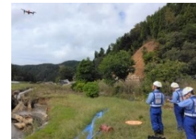
被災状況の調査 (令和6年9月能登半島大雨・石川県輪島市)
