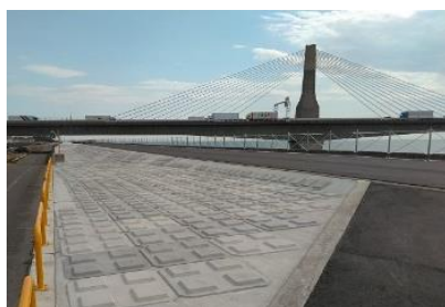
低炭素型コンクリートブロックの活用事例
