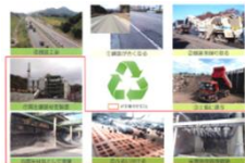
<アスファルト舗装のリサイクル>
